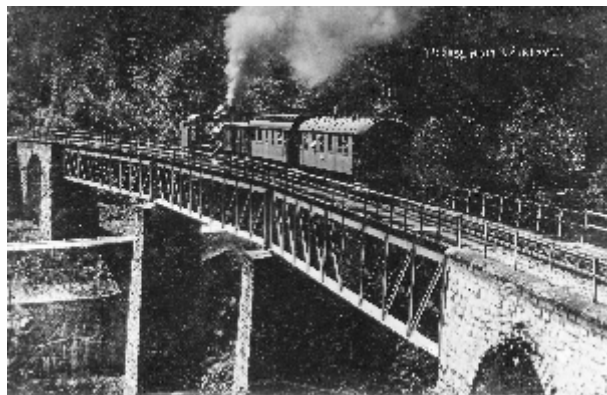
BRÜCKE IN ČERTOVÁ
